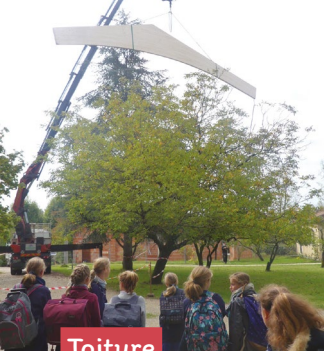
Toiture à Saint-Macaire
