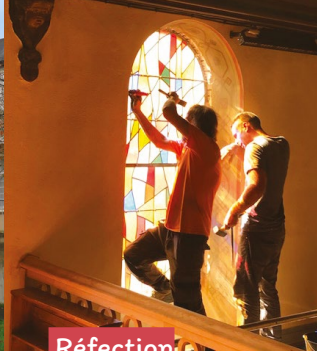
Réfection des vitraux à Montauban
